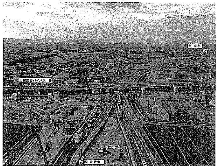
大和御所道路(橿原高田IC付近)
