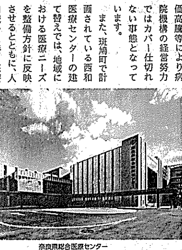
奈良県総合医療センター
