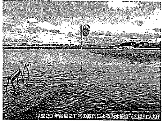
平成29年台風21号の豪雨による内水被害（広陵町大場）
